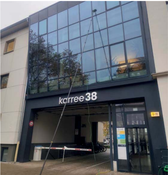
Hoch hinaus für klare Sicht: Glasfassadenreinigung im Karree38 – mit innovativer Reinwasser-Technik für Nachhaltigkeit und Sicherheit.
