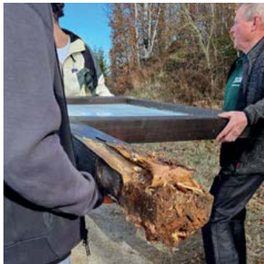
Spuren der Zeit: Viele Stationen des Auferstehungswegs zeigten deutliche Verwitterung – wie dieser vollständig durchgefaltete Balken.
